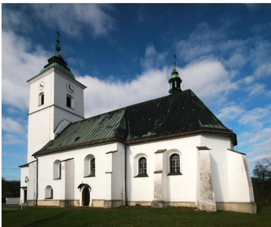
Kostel Nanebevzetí Panny Marie ve Fryčovicích
